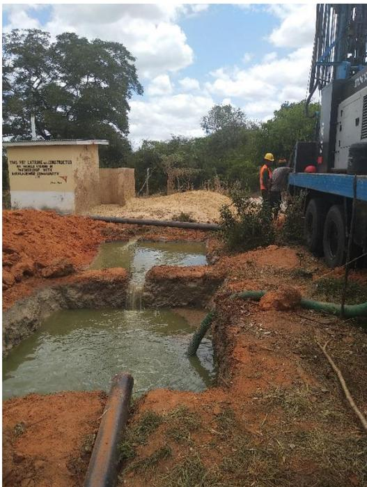
**Becken für die auf Wasser basierende Bohrung**
